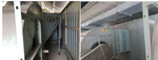
อาคารติดตั้งระบบอัดอากาศสำหรับบันไดหนีไฟและลิฟต์ดับเพลิง ที่ชั้นลาดฟ้า
