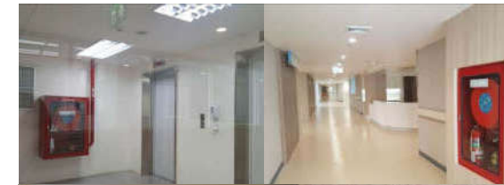
อาคารติดตั้งถังดับเพลิงครอบคลุมพื้นที่อาคารทุกชั้น
