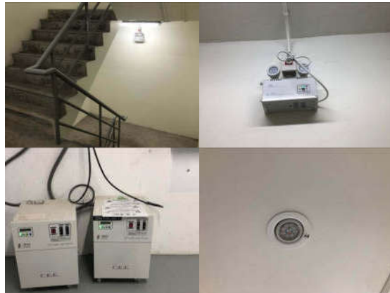
อาคารติดตั้งไฟฟาสารองฉุกเฉินครอบคลุมพื้นที่ทุกชั้น
