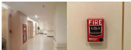
อาคารติดตั้งสัญญาณเตือนเพลิงไหม้ชนิดใช้มือครอบคลุมพื้นที่ทุกชั้น
