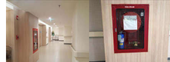
อาคารติดตั้งหัวฉีดดับเพลิง ท่อ Host reel 1 นิ้ว ครอบคลุมพื้นที่ทุกชั้น
