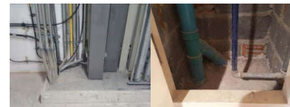
ช่องเดินท่องานระบบไฟฟ้าและประปาใช้วัสดุทนไฟอุดช่องต่อป้องกันไฟลาม
