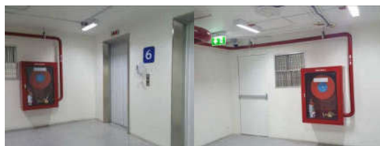
ลิฟต์ดับเพลิงมีตู้หัวลิฟต์ดับเพลิงและระบบอัดอากาศป้องกันควันไฟ
