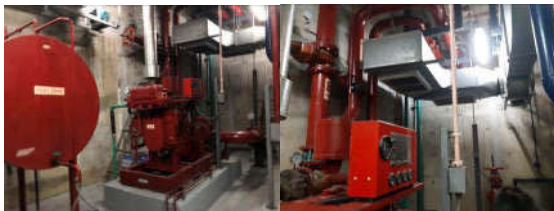
อาคารติดตั้งเครื่องสูบน้ำดับเพลิงเครื่องชนิดดีเซล 1 ชุด และจ็อกกิ้งบีม 1 ชุด
