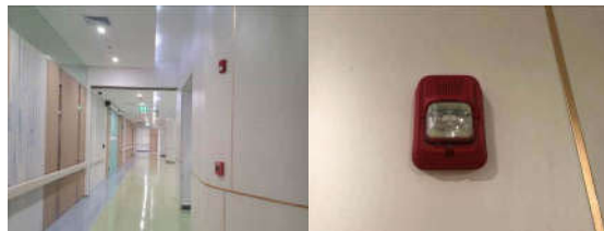
อาคารติดตั้งกระดิ่งสัญญาณเตือนเพลิงไหม้ครอบคลุมพื้นที่ทุกชั้น
