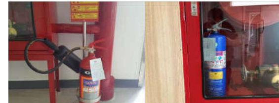
อาคารติดตั้งถังดับเพลิงครอบคลุมพื้นที่อาคารทุกชั้น
