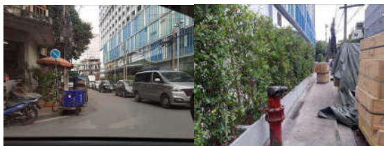
อาคารติดตั้งหัวรับน้ำดับเพลิงด้านข้างอาคาร และท่อประปาหัวแดงด้านหน้าอาคาร
