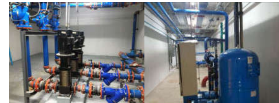
อาคารติดตั้งเครื่องสูบน้ำใช้ จำนวน 3 ชุด ที่ชั้นใต้ดิน และ บิวเตอร์บีมที่ชั้น 10
